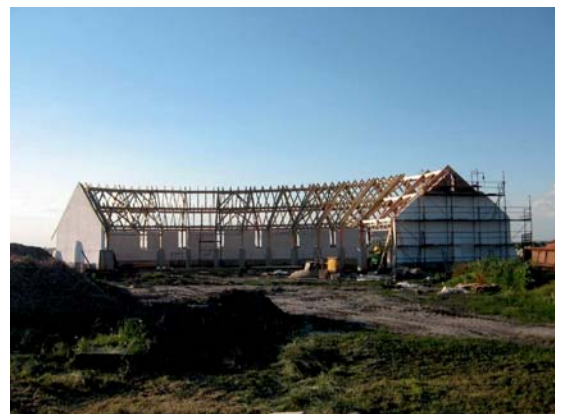
Kardoskút, Sóstói Szarvasmarhatelep rekonstrukciója Rétegelt ragasztott szerkezetű íves keretállások 2014
