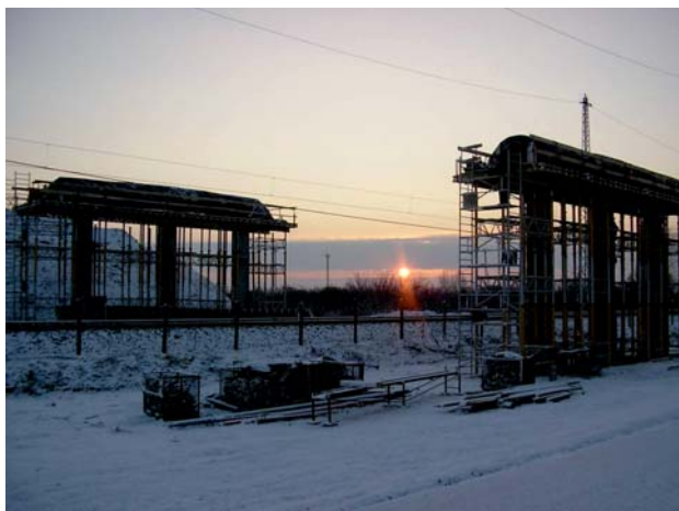
Békéscsaba, északi elkerülő vasúti felüljárója A fejgerendák hőszigeteléssel bevtakarva 2005 decemberében
